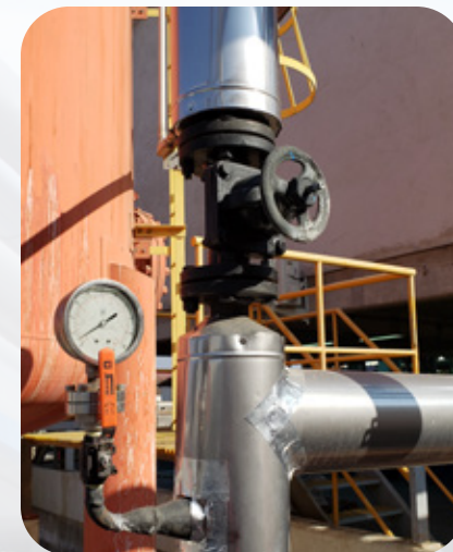
Fabricación y montaje aislamiento térmico, ductos
